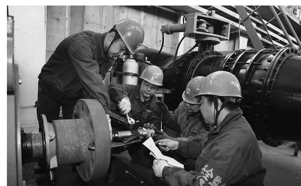
春节临近,河北建投兴泰发电公司开展拉网式安全生产事故隐患排查整治攻坚行动,坚决防范和遏制各类生产安全事件,提升事故隐患排查治理工作水平,为春节期间安全生产稳定奠定基础。图为该公司检修人员在消除设备缺陷。 李红欣 摄
